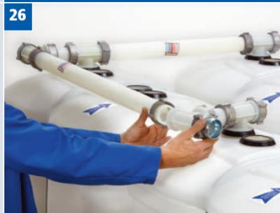
26) Reihenverbindung der Füllleitung an den T-Stücken mit Sieb.
