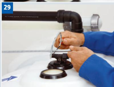
29) Entnahmerohr bei Verwendung des Entnahmekreuzes kürzen.
