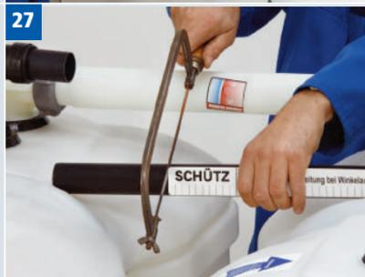
27) Verbindungsrohr Entlüftung bei L-Aufstellung nach beigefügtem Lineal kürzen.
