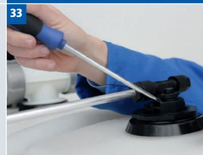
38) PG-Verschraubung lösen, Kabel auf die Klemmen legen und sichern.
